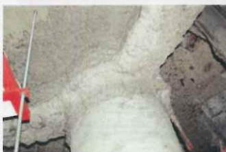
柱や梁に施工 吹付け石綿
