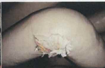
エルボ部に使用 石綿含有保温材
