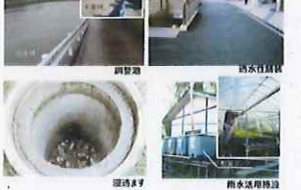
雨水貯留浸透施設の例
